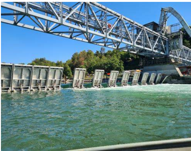
Figura 3: Portine nuove installate
