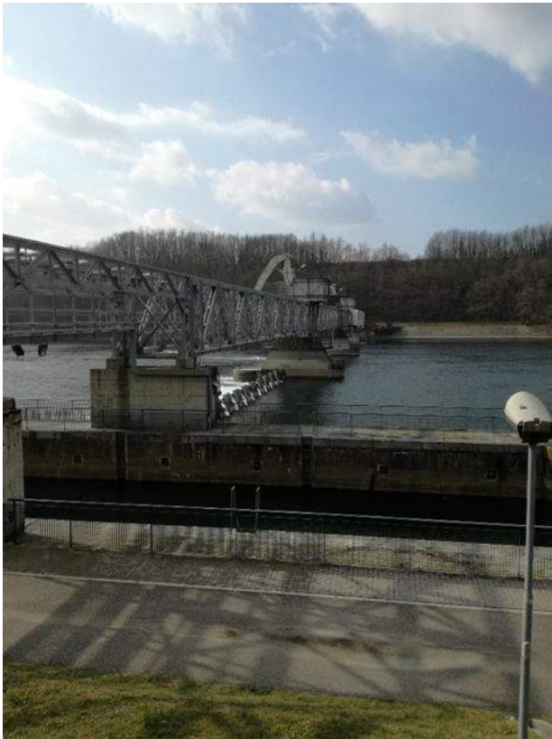
Figura 1: Vista della traversa della Miorina
