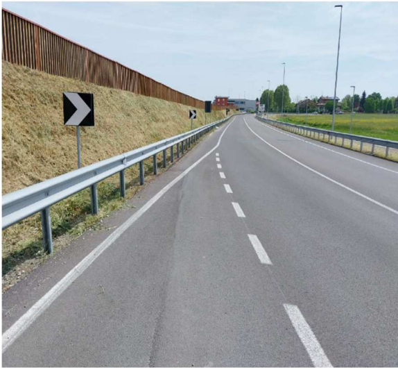
Foto 4: Vista est tratto in rilevato
